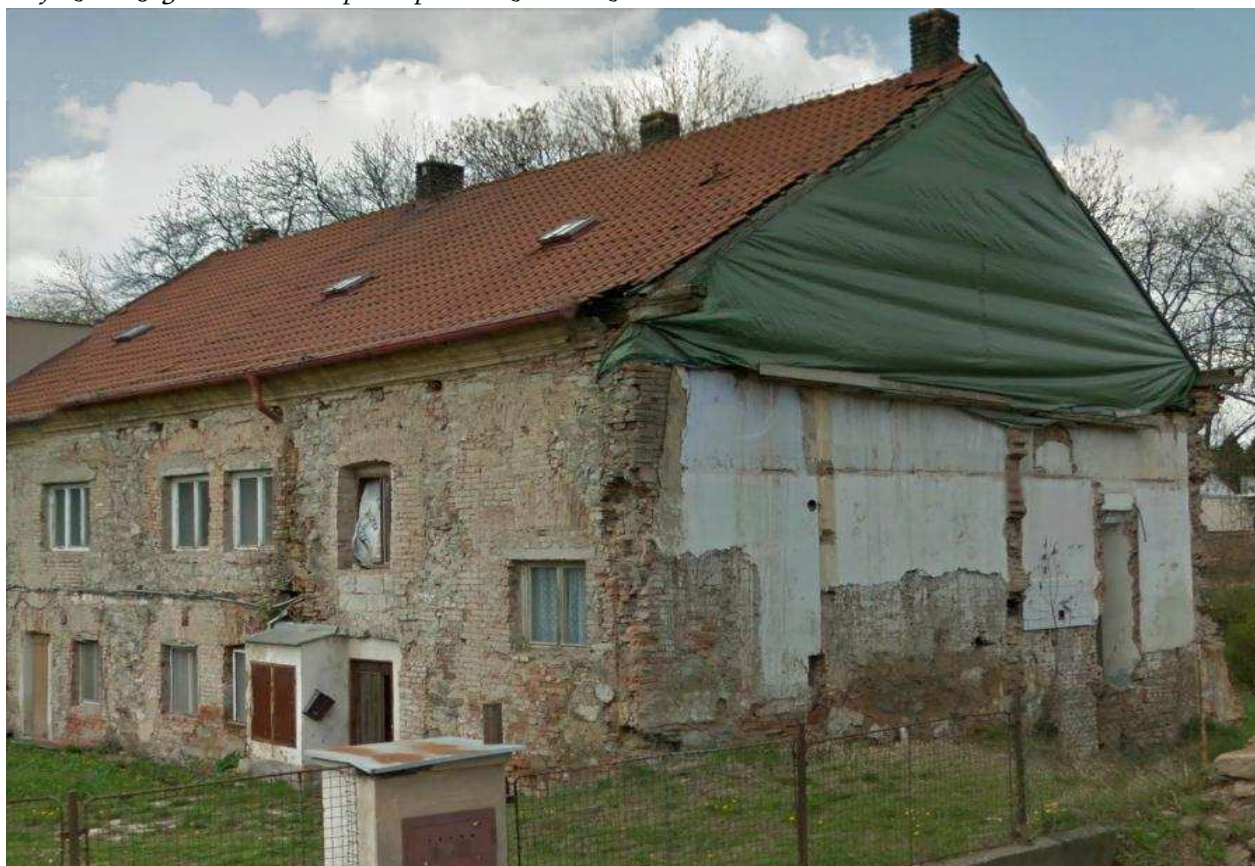
Objekt v Riegerově ulici č. p. 65 před rekonstrukcí
