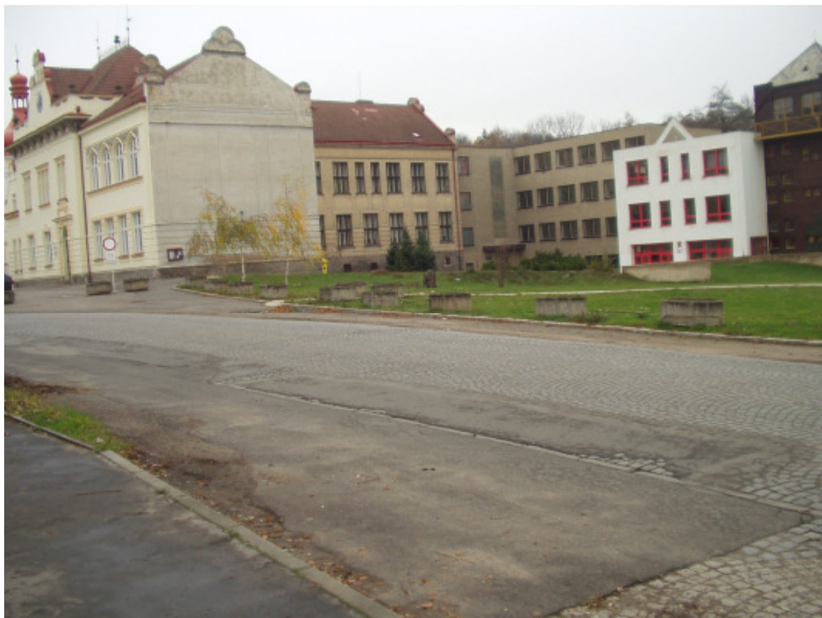
Chystá se dostavba školy ...
