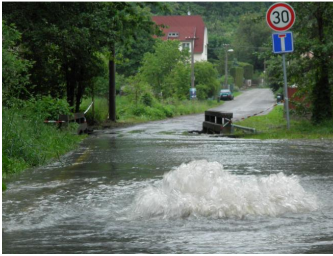
FOTO – vyvěrající kanalizační řad před mostkem do ulice Horova u koupaliště. 2.6.2013, v 11:31 již zbarveno povrchovou vodou z Výmoly
