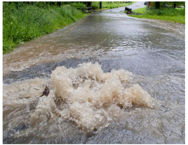
FOTO – vyvěrající kanalizační řad před mostkem do ulice Horova u koupaliště. 2.6.2013, v 11:31 již zbarveno povrchovou vodou z Výmoly
