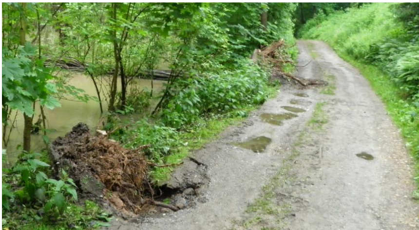
FOTO – vyvrácené stromy na komunikaci Bendlova stezka, blíže k mlýnu – 3.6.2013 17:58
