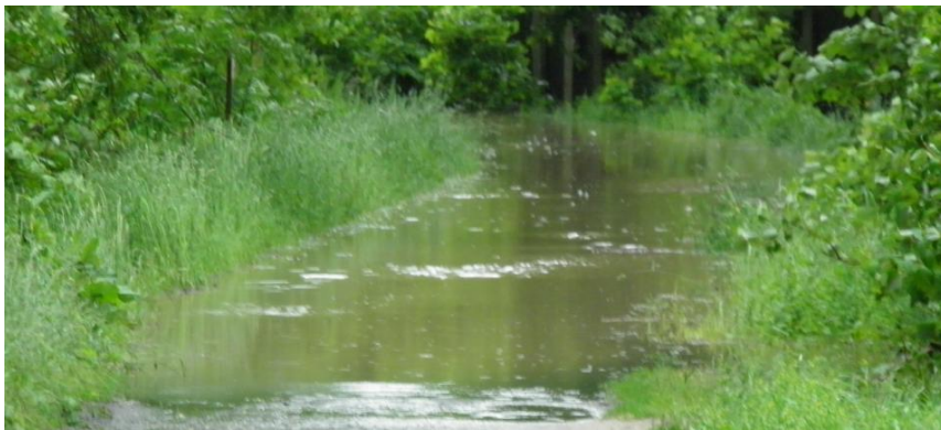
FOTO – zaplavení obslužné komunikace nad kanalizací, levý břeh Mlýnského rybníka, 2.6.2013 8:36
