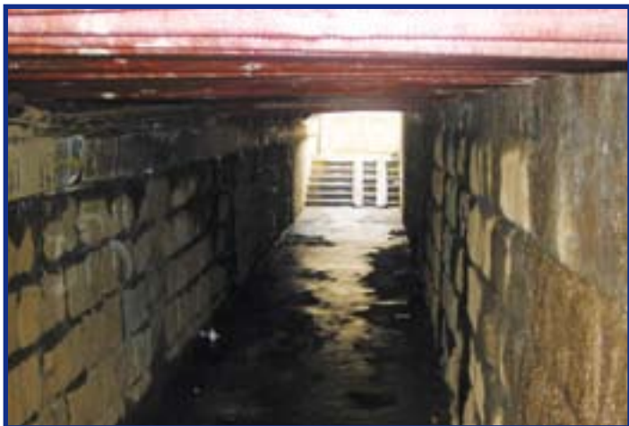
Současný stav podchodu u železničního přejezdu foto M. Svoboda
